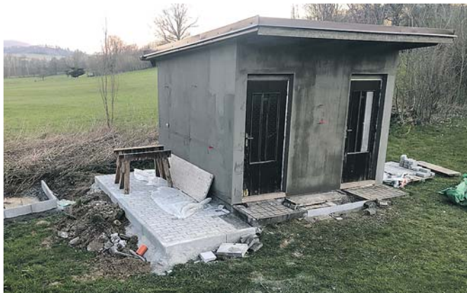
Toalety na koupališti ve Smržovicích.
